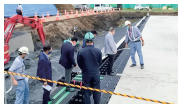
柳崎公園下に大型貯留施設を整備
