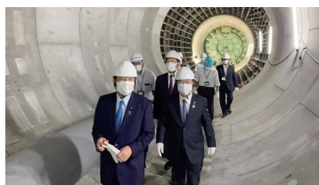
周辺道路下に大型貯留管を整備
