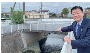
浸水原因となった護岸を改修
