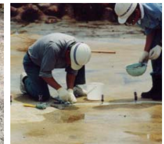
クラック補修状況(注入工)
