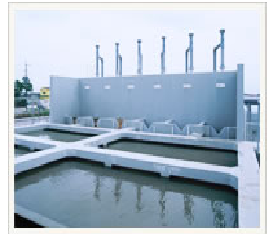
地下水から天然ガスを分離するセパレーター(分離槽)
