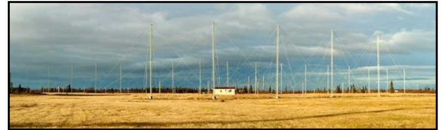
NICTがアラスカのキングサーモンに設置した大型HFレーダ
