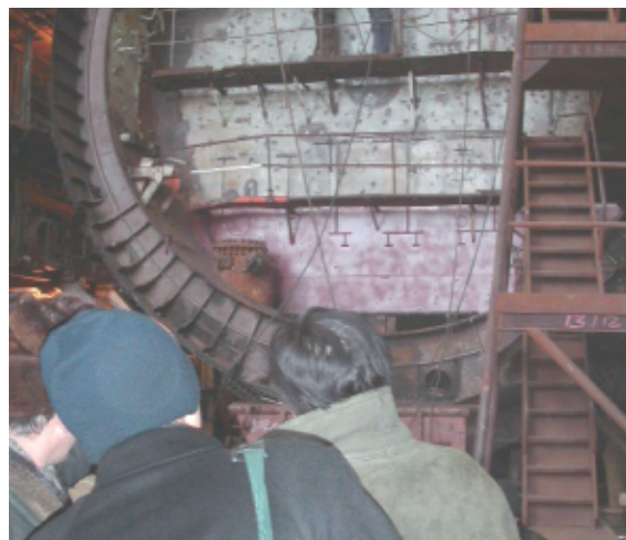
原子炉区画をコンクリートで封鎖
