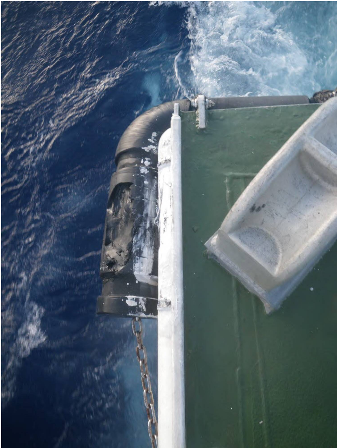
画像3 巡視船みずきの損傷状況
