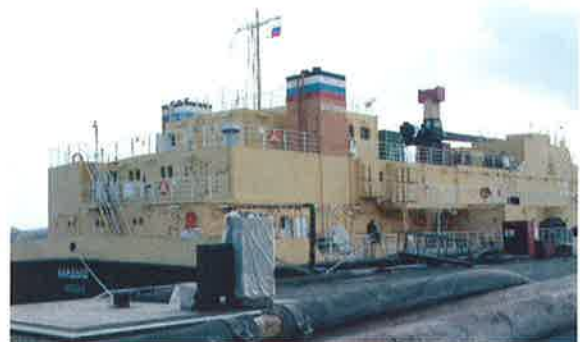
日本の支援で完成した液体放射性廃棄物処理施設「すずらん」
