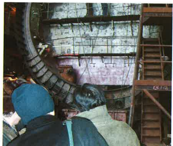
原子炉区画をコンクリートで封鎖
